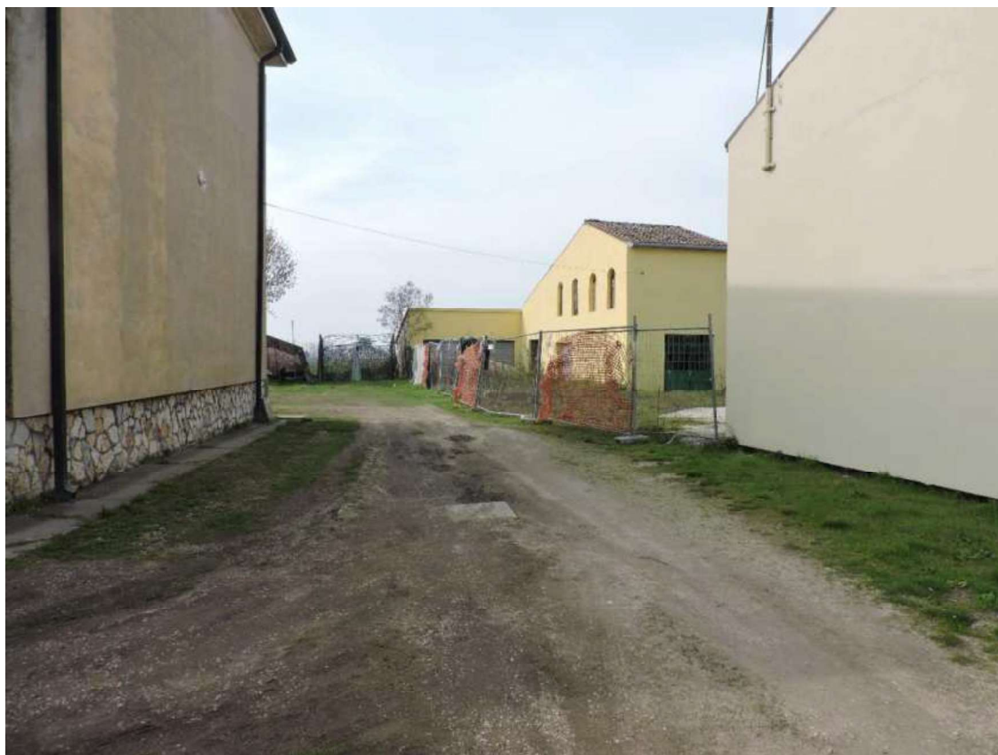
Foto 3 ingresso alla corte e fabbricati retrostanti
