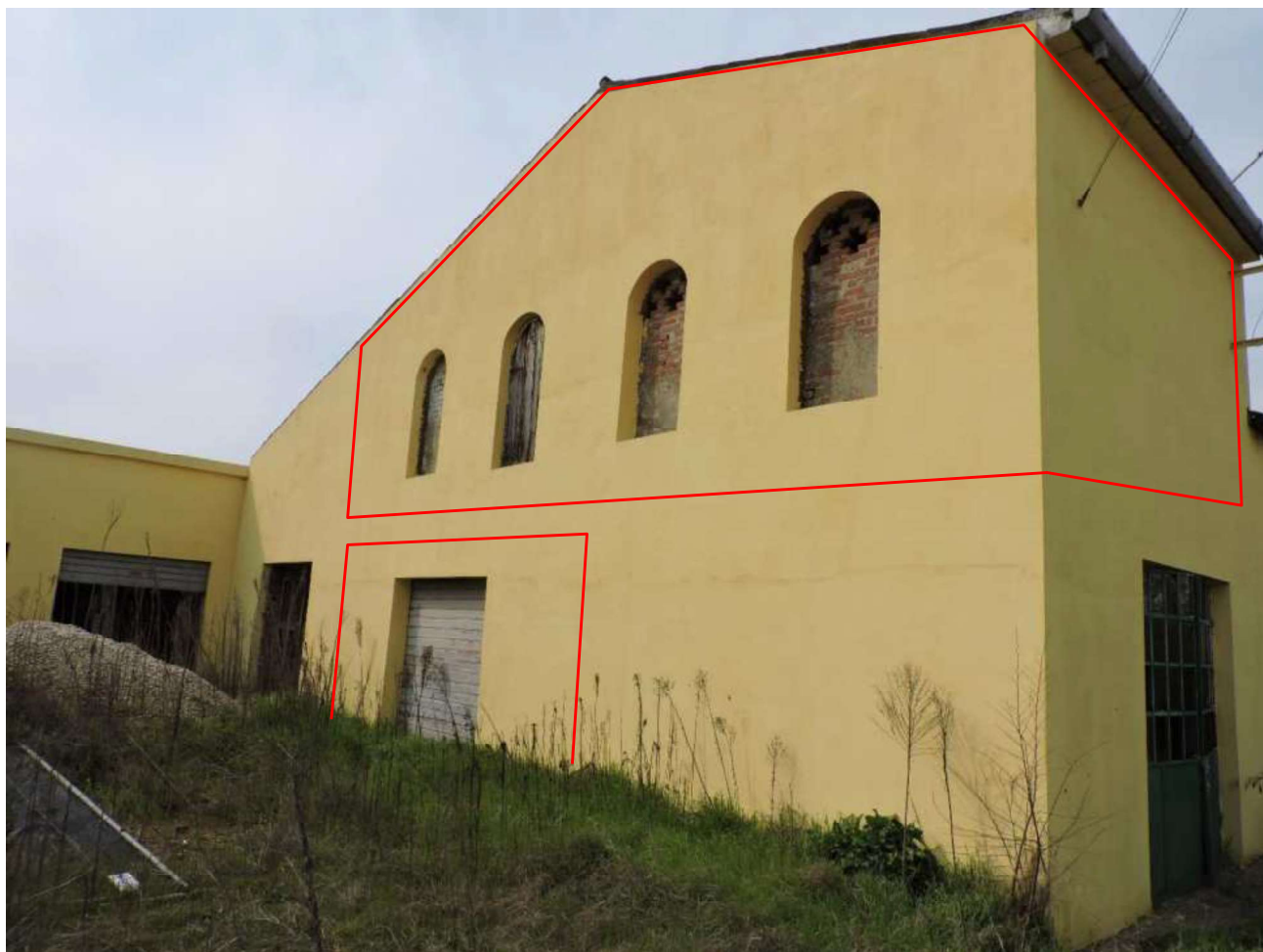
Foto 42 Autorimessa Part. 39/4 e Soffitta/magazzino Part. 39/3 non visionate internamente
