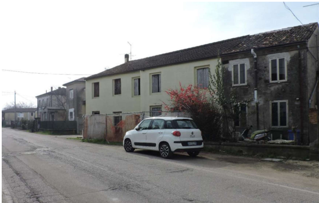
Foto 1 Fronte via Campagnol – fabbricato abitativo
