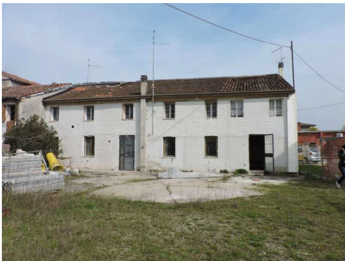
Foto 4 Fronte posteriore fabbricato abitativo
