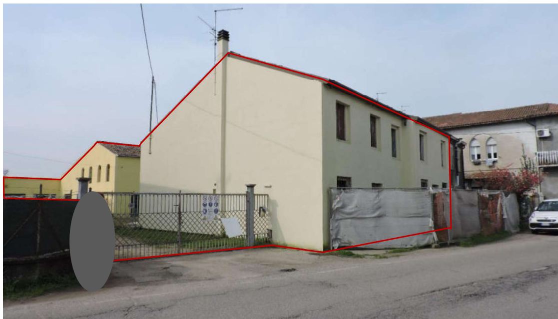
Foto 2 Fronte via Campagnol e accesso alla corte
