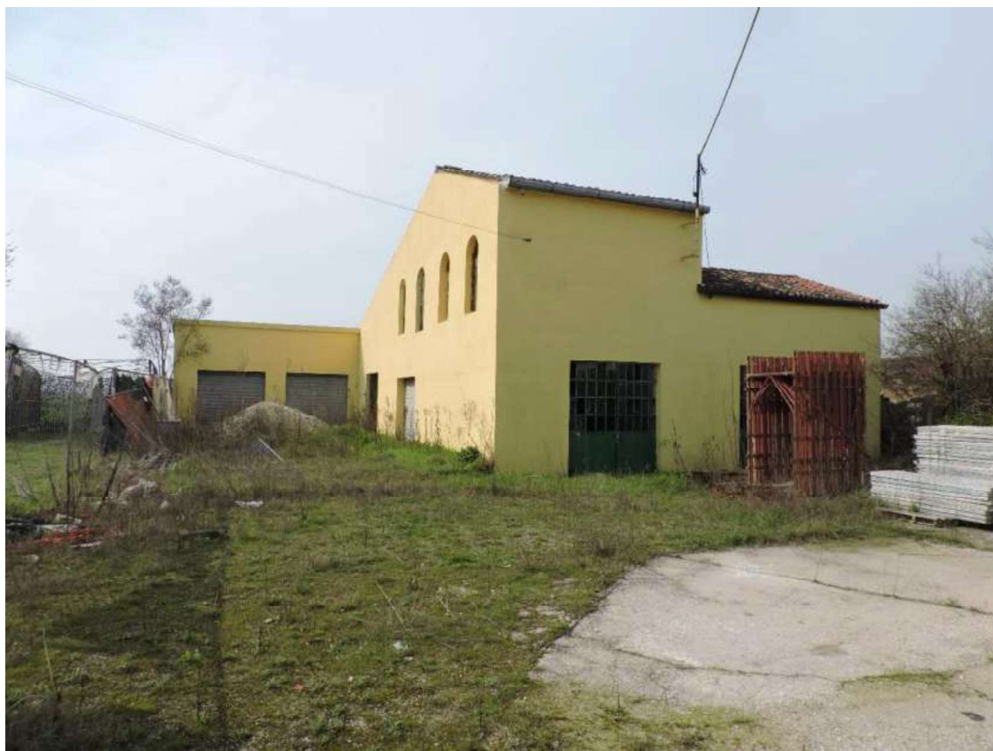
Foto 5 Fabbricati non abitativi Part. 39
